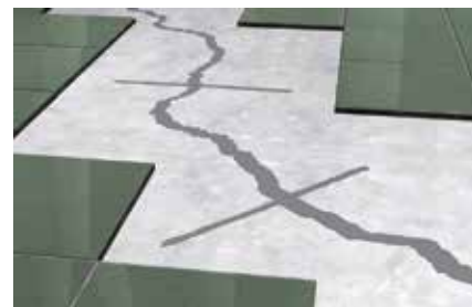
Sigillatura di fessure
