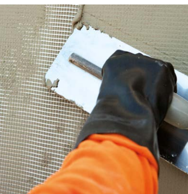
Annegamento della rete in fibra di vetro e applicazione della seconda mano di Rasocem KR.
