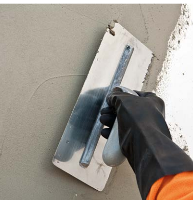
Applicazione di Rasocem KR con spatola metallica liscia.
