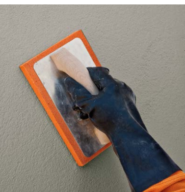
Finitura della superficie di Rasocem KR con fratassino di spugna.
