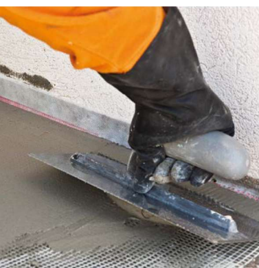
Applicazione di Poligum A+B con spatola metallica liscia
