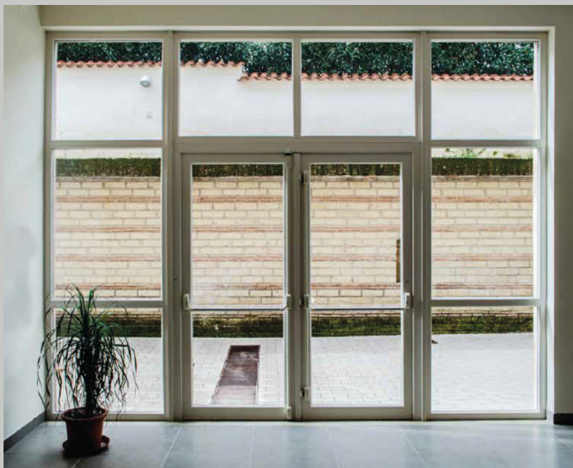
Porte apertura esterna con maniglione antipanico
