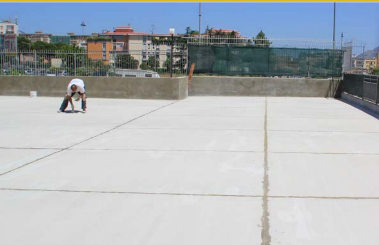
La pavimentazione non è una superficie continua a causa della presenza dei giunti. I giunti possono essere di vari tipi (di isolamento, dilatazione, contrazione) e svolgere le diverse funzioni. Identificare il tipo e la funzione dello specifico giunto è fondamentale per trattare in modo ottimale questi punti di criticità del sottofondo, al fine di mantenere la funzionalità, garantendo la continuità del rivestimento.
